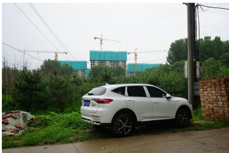
照片 2-10 规划用地西北侧在建建筑
