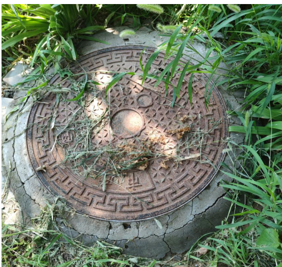
项目内污水井
