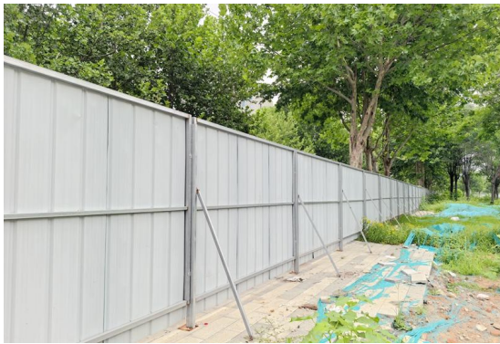
项目北侧围挡
