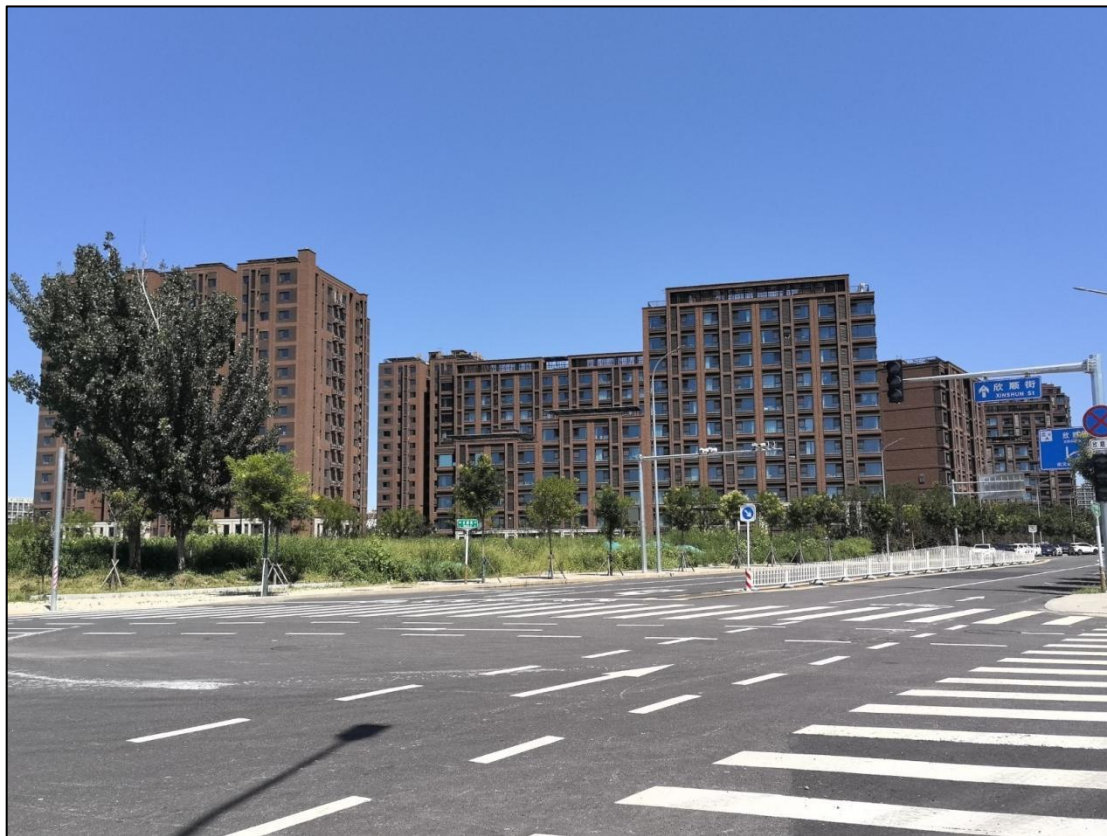
照片 2-1 建设用地北侧道路及建筑
