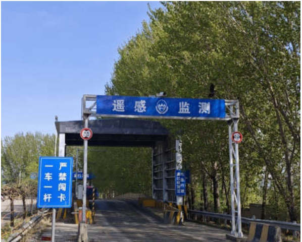
现况环保检测初检车道
