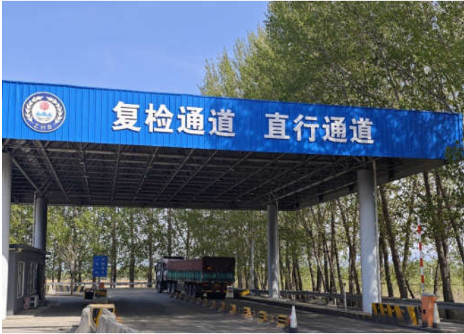
现况环保检测复检车道
