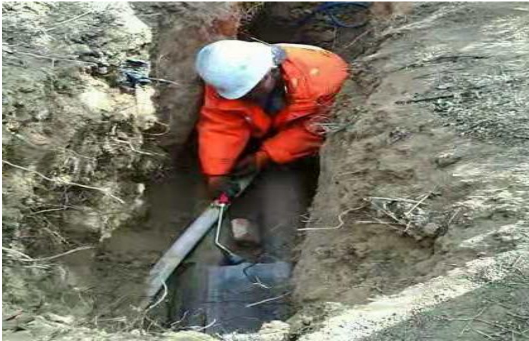
图 2-1-21 隧道外消防管道冰冻处理现场图
