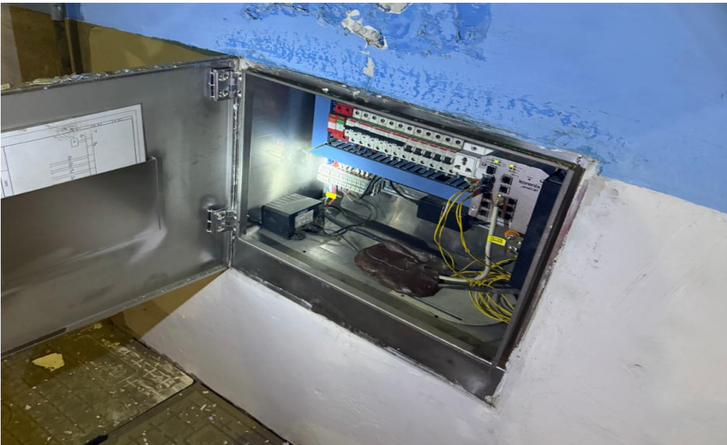
图 2-4-6 隧道设备箱洞室防水处理后效果图
