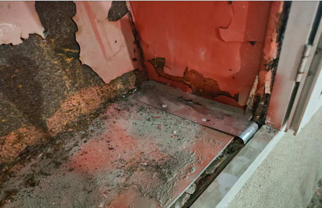
图 2-2-10 消防栓箱现状图
