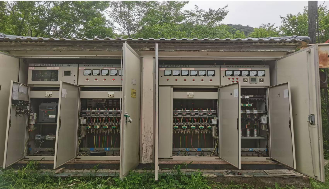
图 2-2—1 瓦庙隧道箱式变电站现状图
