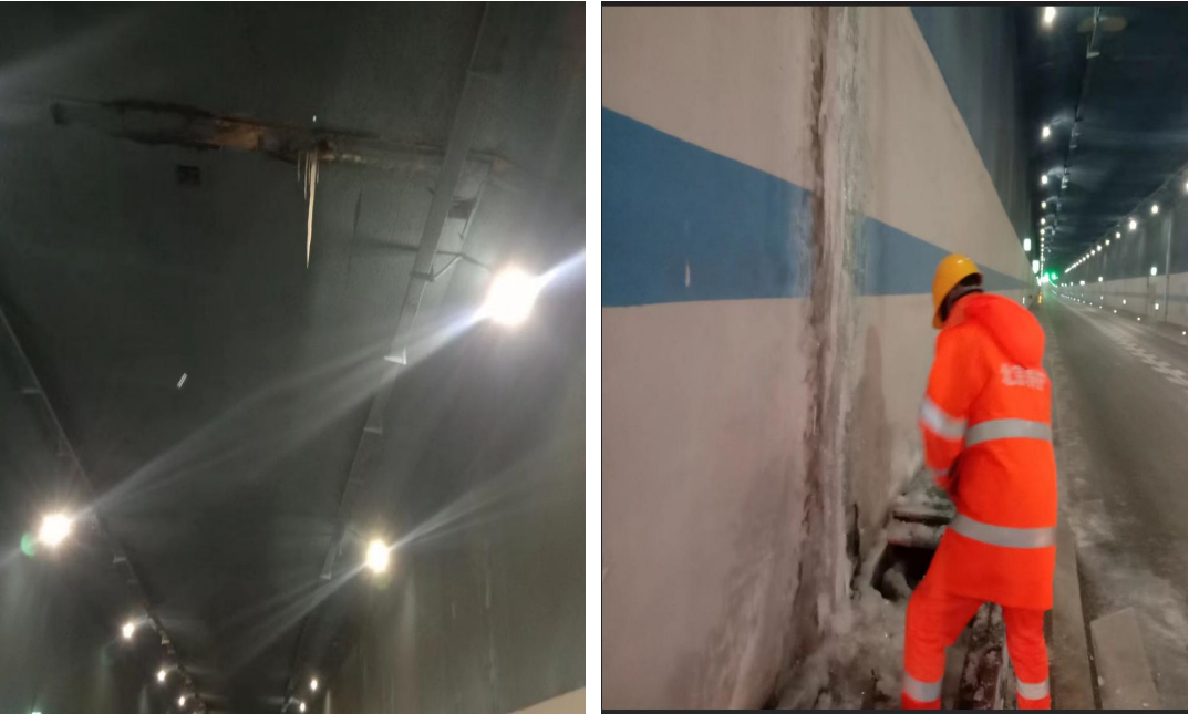
图 2-4-8 隧道除冰现场图
