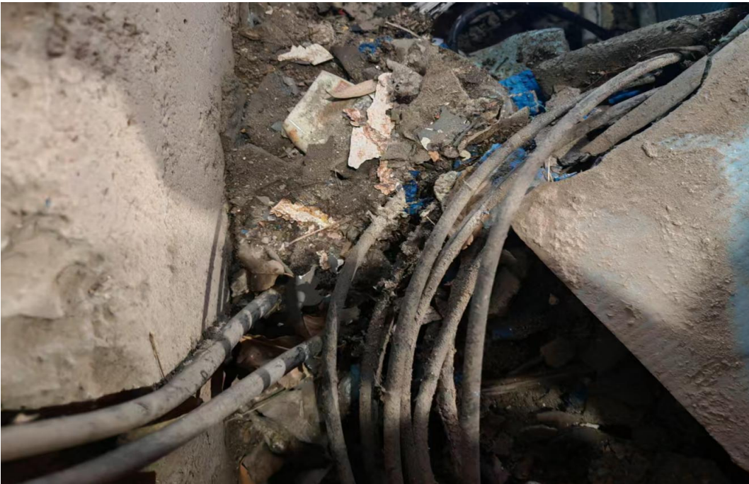
图 2-2—5 瓦庙隧道电缆现状图
