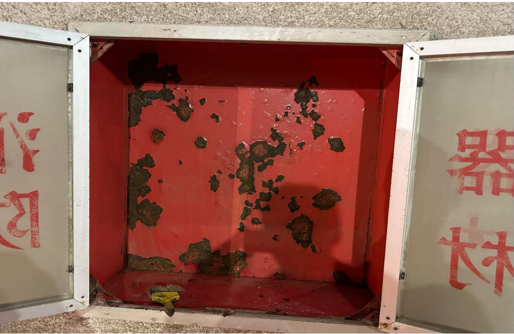
图 2-2-11 消防栓箱现状图
