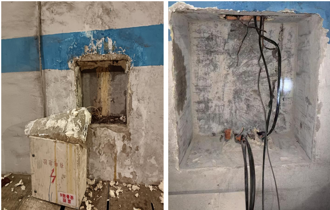
图 2-4-4 隧道设备箱洞室防水处理图
