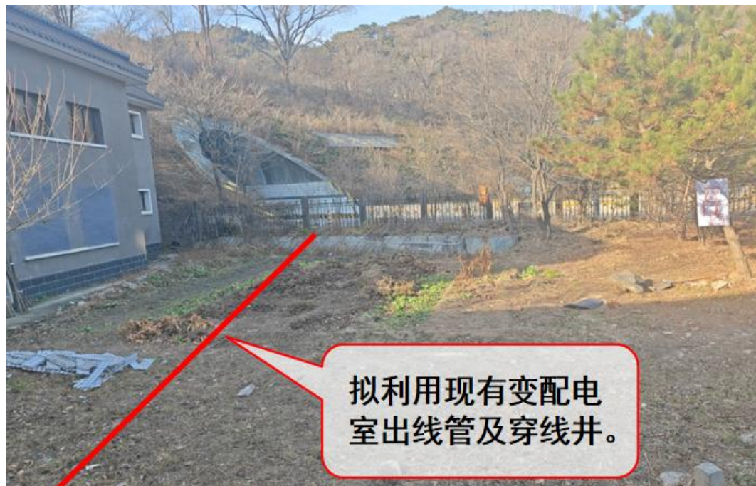
图 2-1-11 青龙桥隧道 1#变电所电缆路径示意图
