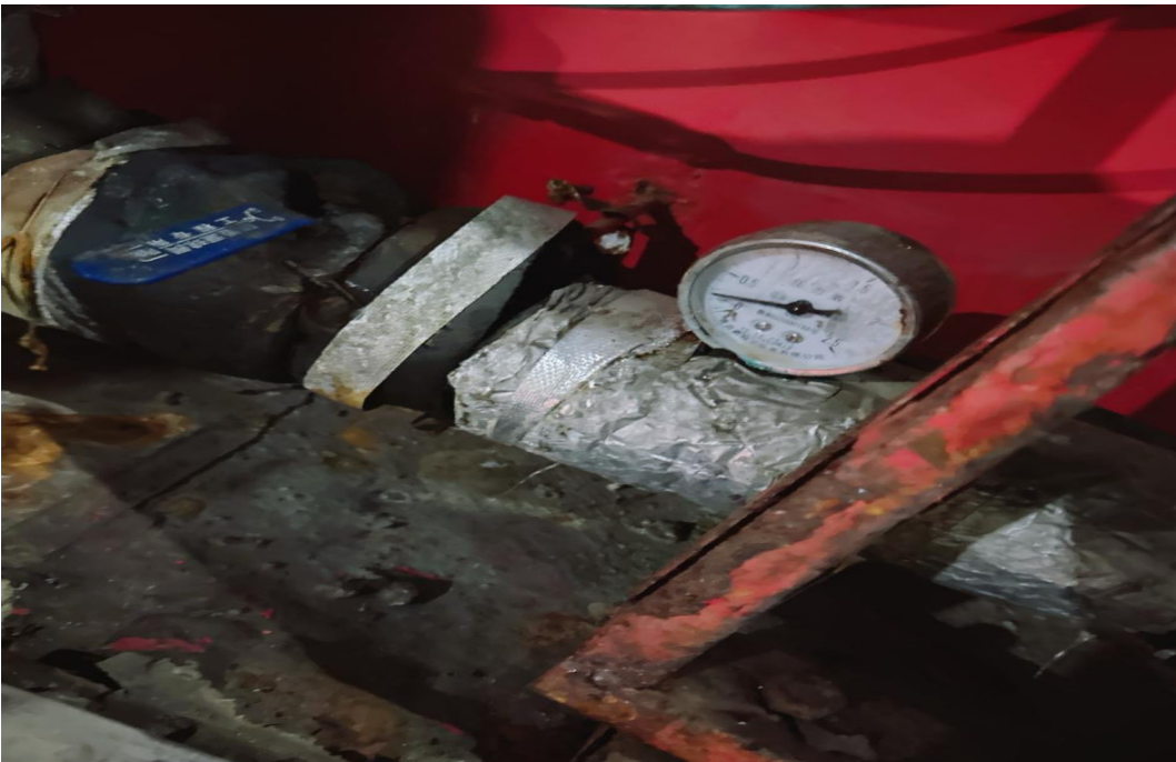
图 2-4-2 隧道设备箱现状图
