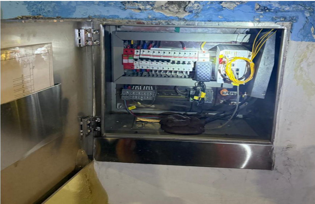
图 2-4-5 隧道设备箱洞室防水处理后效果图
