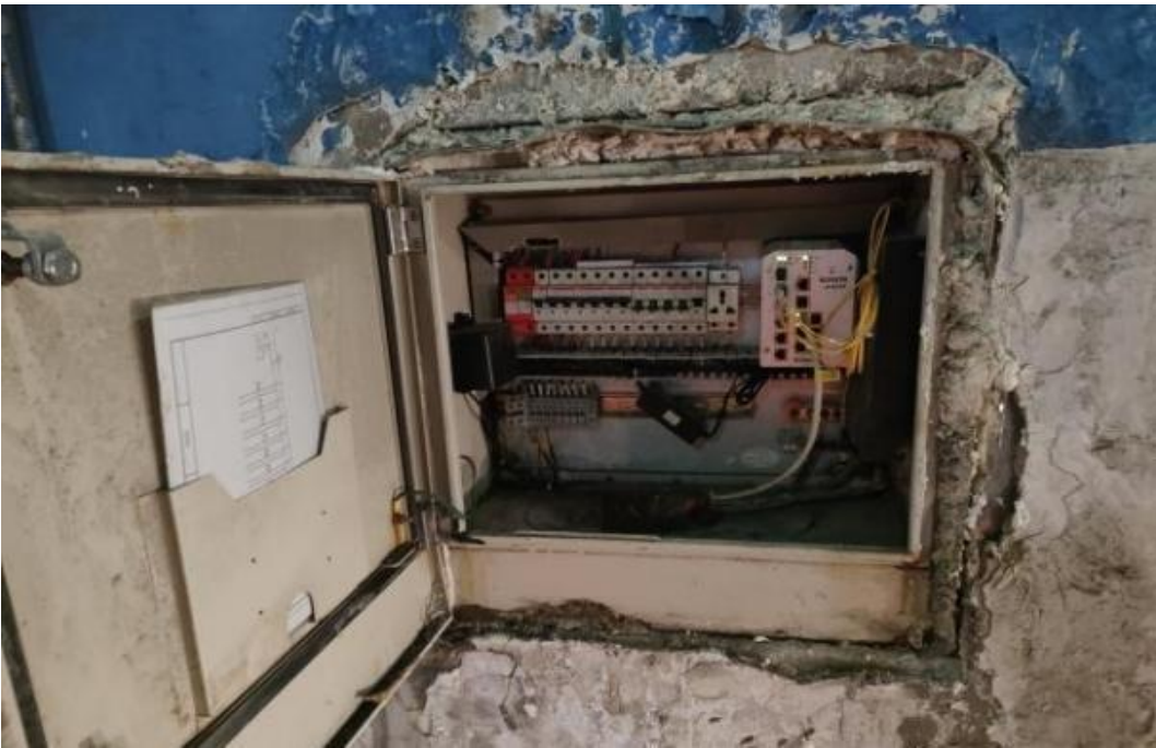
图 2-4-1 隧道设备箱现状图
