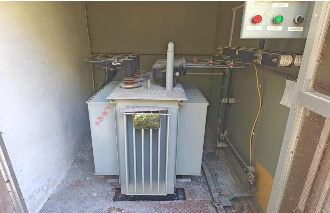
图 2-2—2 瓦庙隧道箱式变电站现状图
