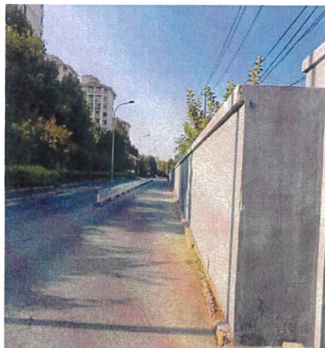
项目东侧围墙情况
