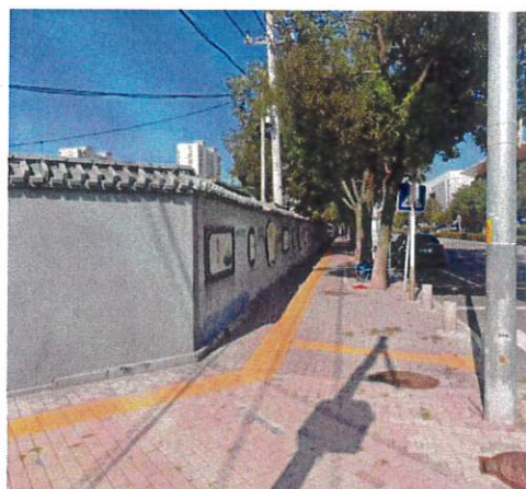
项目北侧围墙情况
