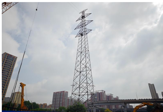
项目内高压塔
