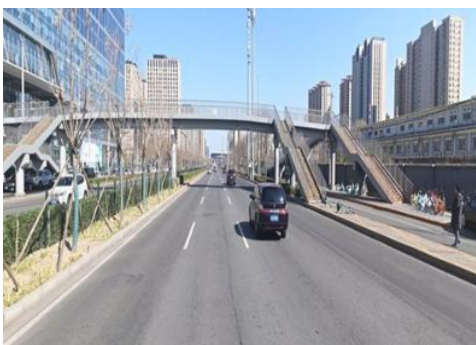
图 2-20 广渠路人行天桥二
