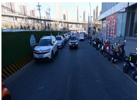
图 2-21 大郊亭北街现状道路
