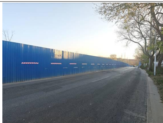
场地西侧金顶山路
