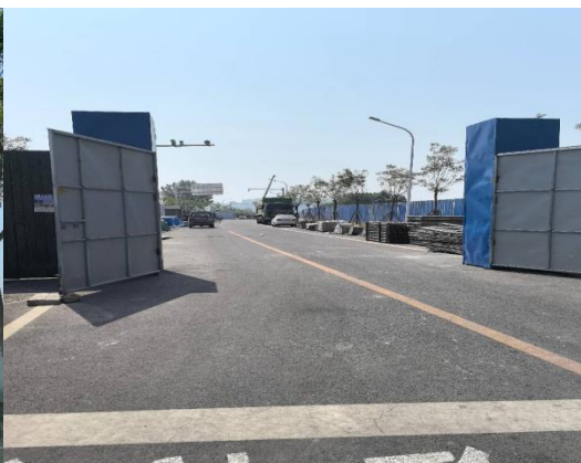
图 2-22 场地内现有建筑（西向）
