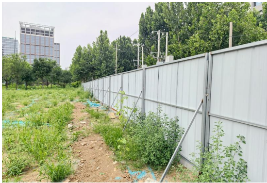
项目北侧围挡
