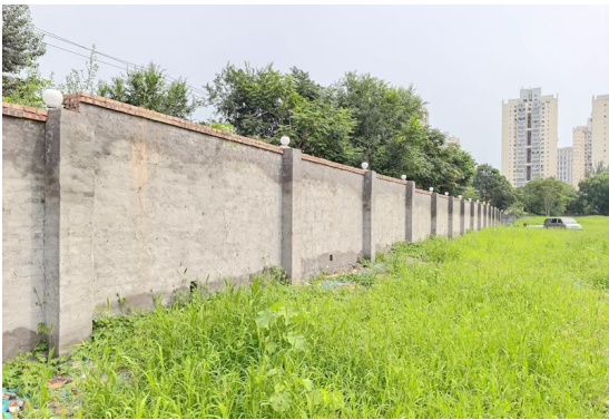
项目东侧围墙
