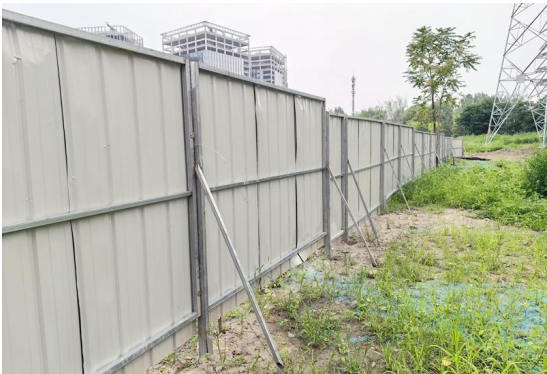
项目西侧围挡
