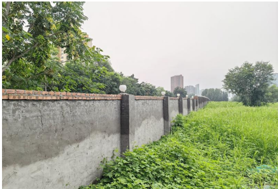
项目南侧围墙
