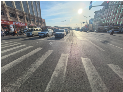
图 2.1-3 现状京榆旧线西口
