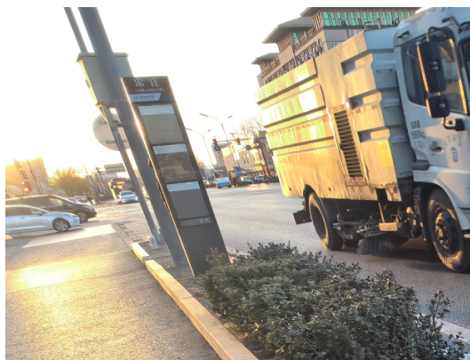
废弃公交站牌拆除
