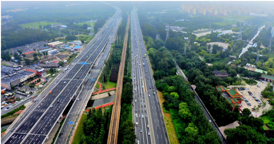
北小河（首都机场高速桩号 K6+985）
