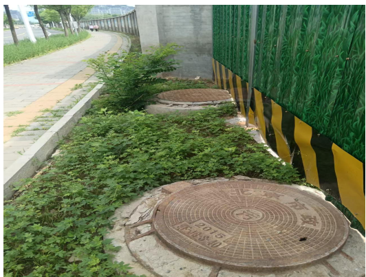
地块 7 污水井、雨水井
