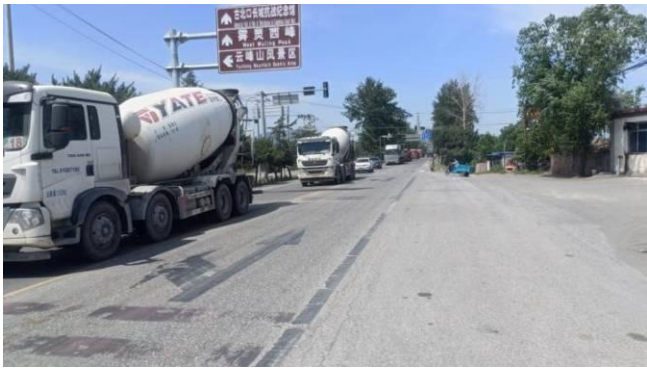
标线磨损严重
