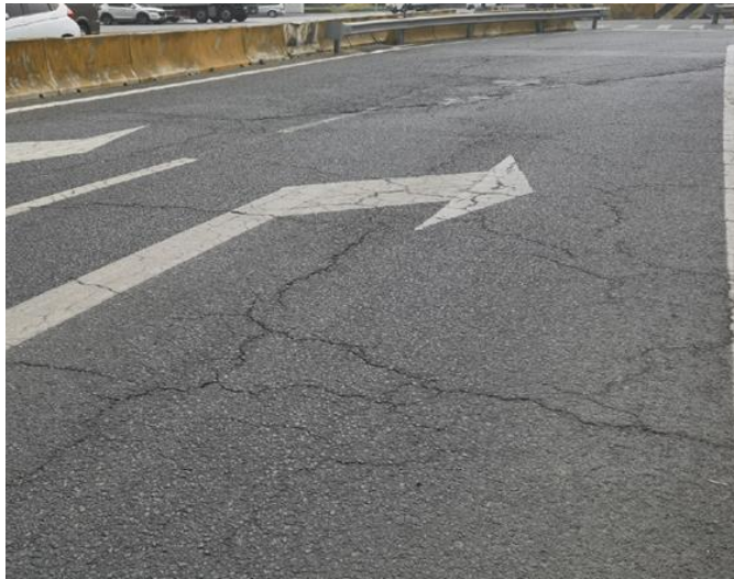
图 2.6-4 路面裂缝
