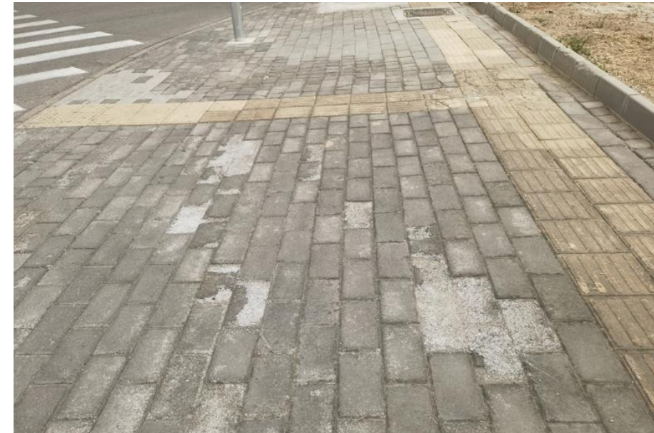
图 2.7.2-1 步道破损
