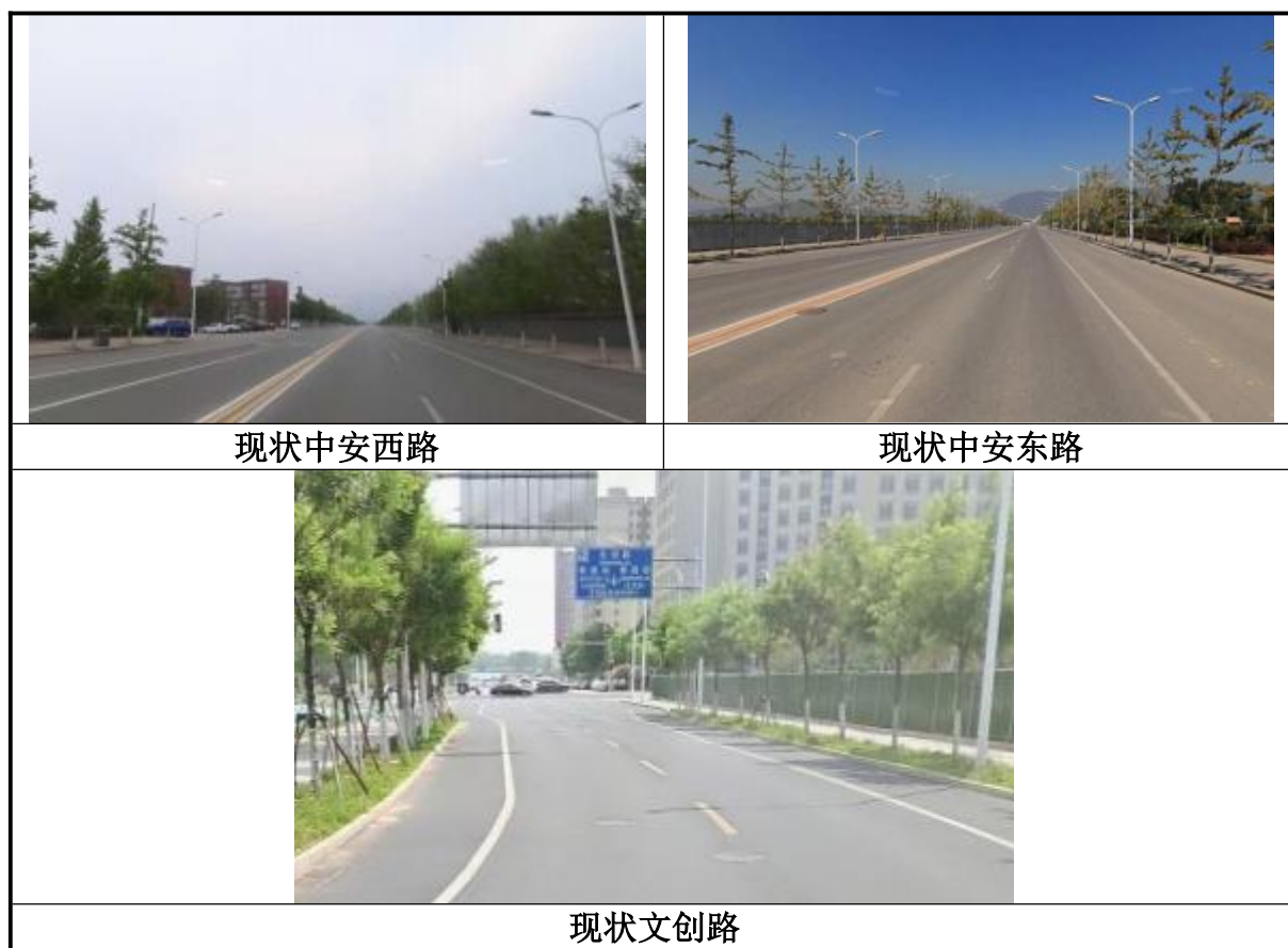
图 3.1-1 临近道路现状
