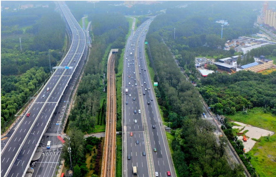
机场快轨线（K8+400 下穿段）
