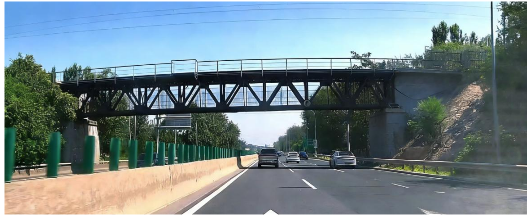
东北环线铁路（首都机场高速桩号 K6+650）
