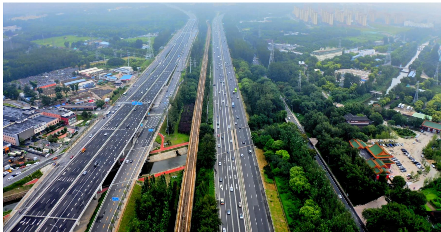
北小河（首都机场高速桩号 K6+985）
