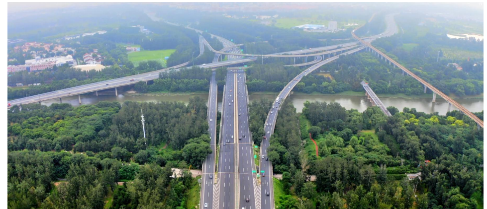
温榆河（首都机场高速桩号 K13+300）
