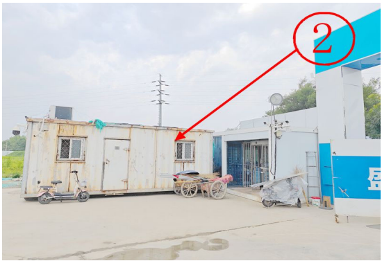
项目内未拆除建筑
