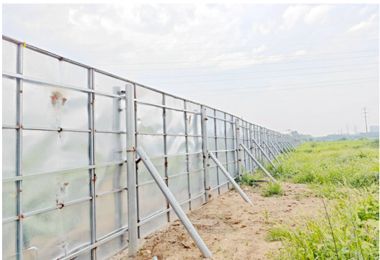
项目西侧围挡
