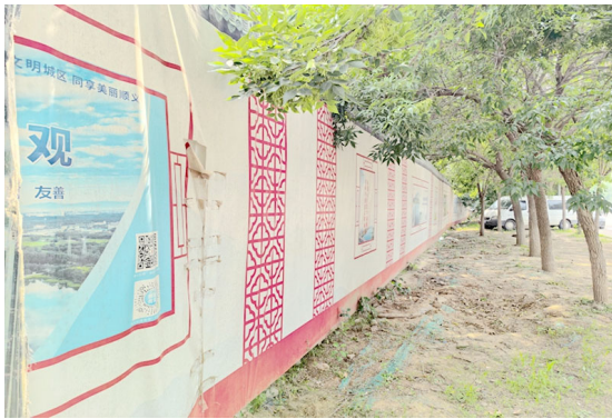
项目北侧围挡
