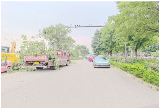
项目西侧现状道路
