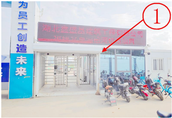
项目内未拆除建筑
