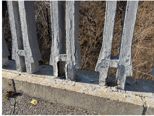
图 2.4.2-2 混凝土护栏和地袱锈胀露筋
