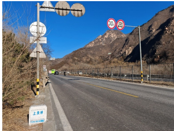
图 2.4.4-2 桥梁整体状况良好
