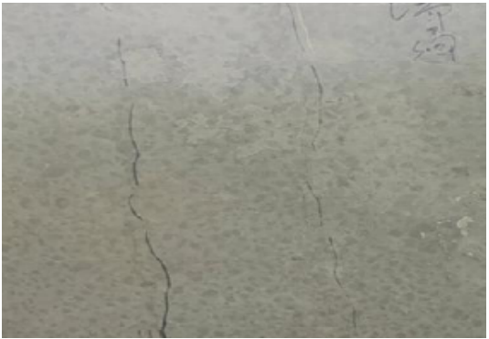
图 2.4.2-3 主梁锈胀开裂（左）和裂缝（右）
