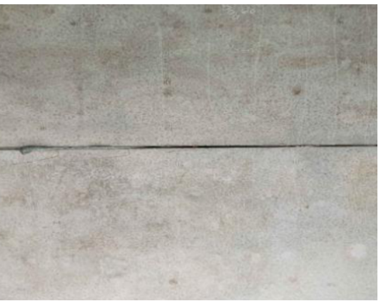
图 2.4.2-4 铰缝脱落
