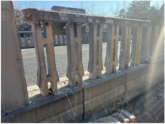
图 2.4.2-2 混凝土护栏和地袱锈胀露筋
