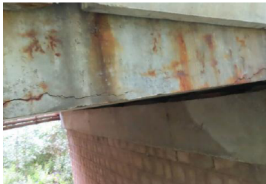
图 2.4.2-3 主梁锈胀开裂（左）和裂缝（右）
