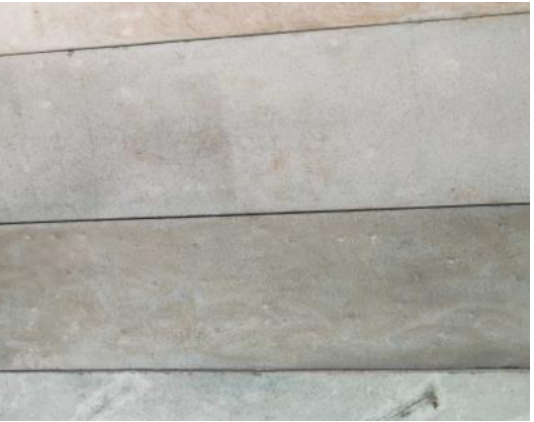
图 2.4.2-4 铰缝脱落
