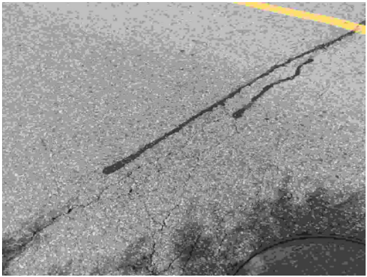
图 2.4.2-1 桥面铺装裂缝
