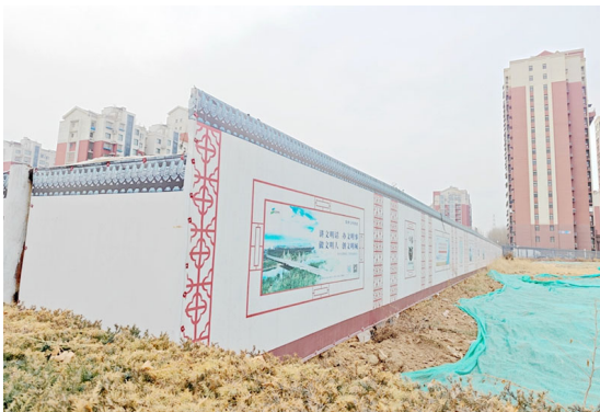
项目北侧围挡
