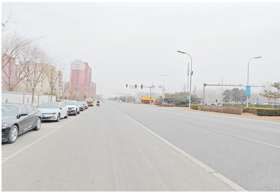
项目南侧现状道路
