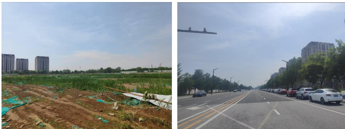
图 2-2 场地及周边道路现状照片
