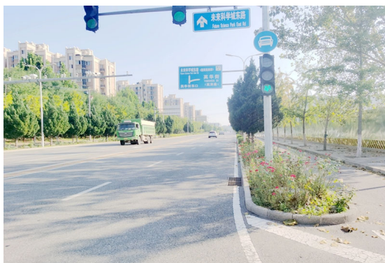
项目东侧现状道路
