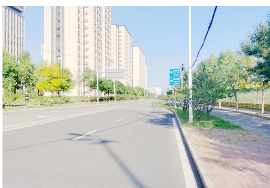
项目北侧现状道路
