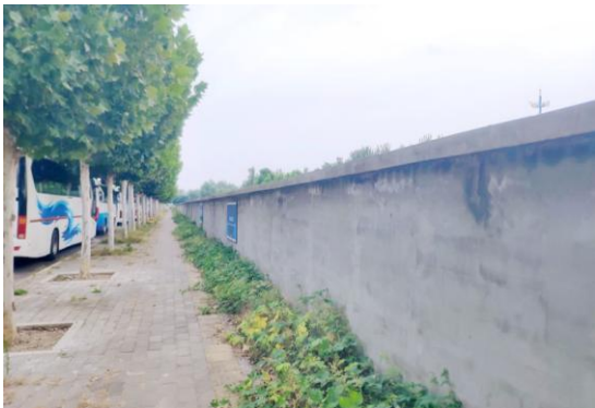
项目北侧围墙
