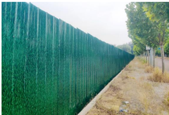
项目西侧围挡
