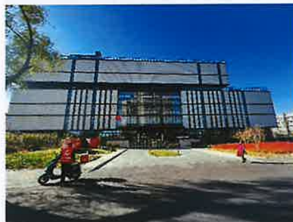
图 2-6 朝阳区档案馆（新馆）
