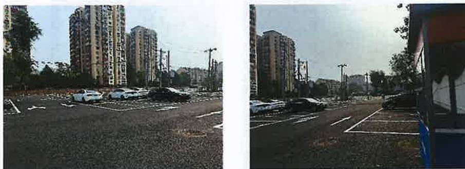
图 2-16 现状新建停车场
