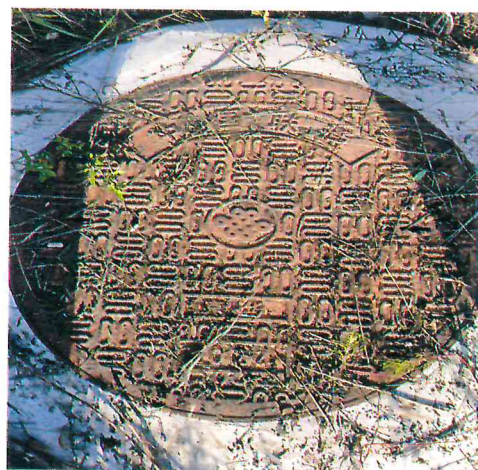
项目内检修井
