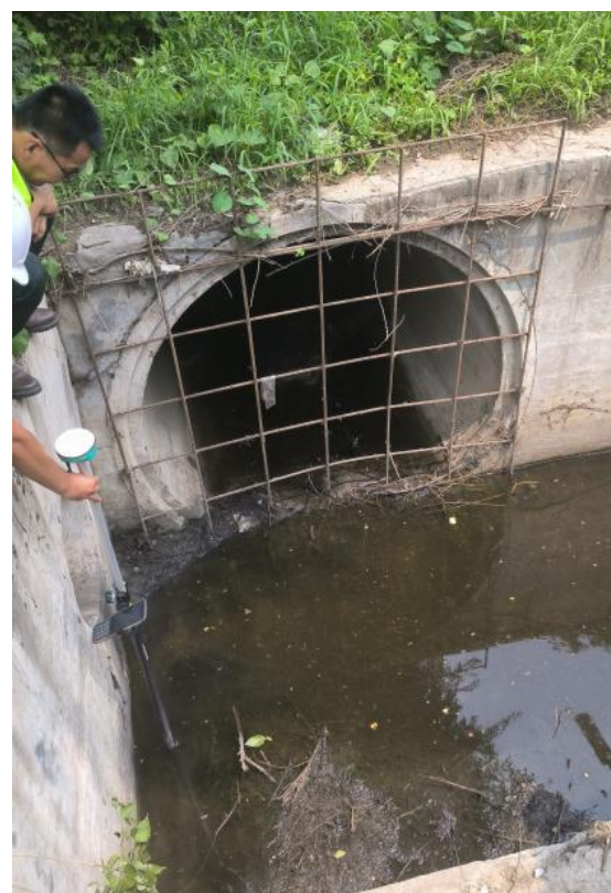
下穿五环路d1800mm管道
