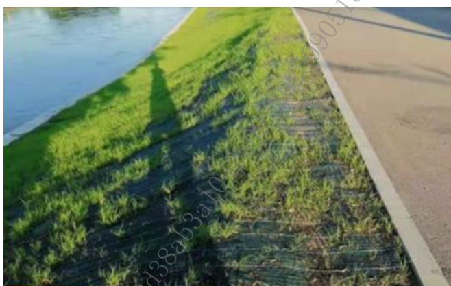
图 4-3 边坡植被恢复工程
