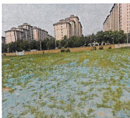
项目内平整情况
