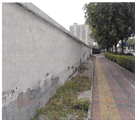
项目西侧围墙情况
