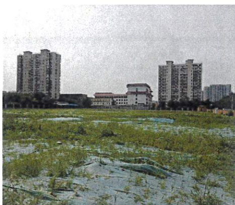
项目内平整情况
