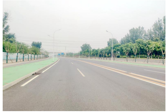
项目东侧现状道路
