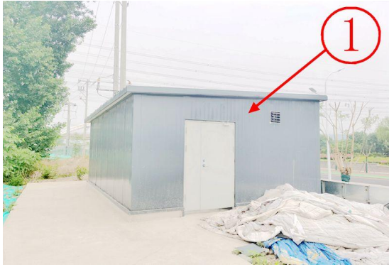
项目内未拆除建筑
