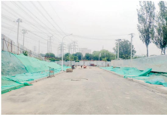
项目北侧现状道路
