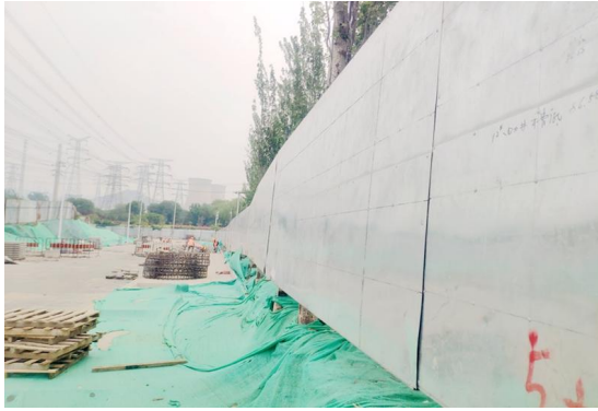
项目北侧围挡
