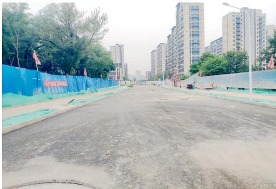
项目南侧现状道路
