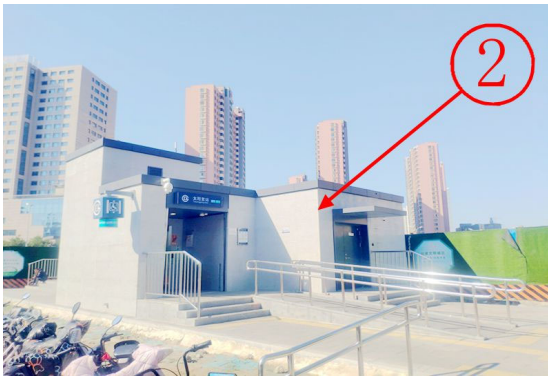
项目内未拆除建筑
