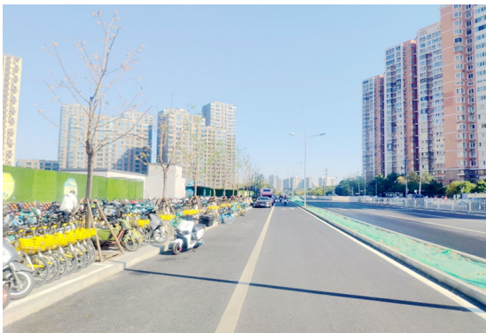
项目南侧现状道路
