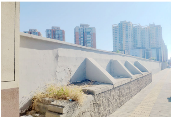
项目西侧围墙
