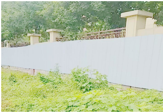
项目北侧围挡
