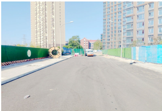
项目东侧现状道路
