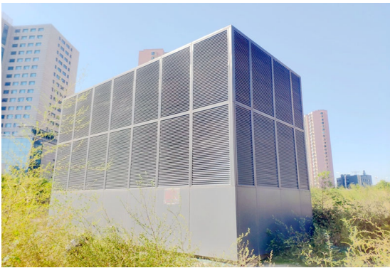
项目内地铁风亭组
