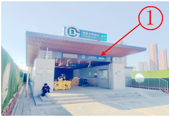
项目内未拆除建筑
