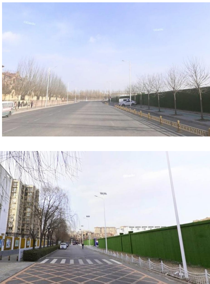
图 2-2 场地周边道路现状照片
