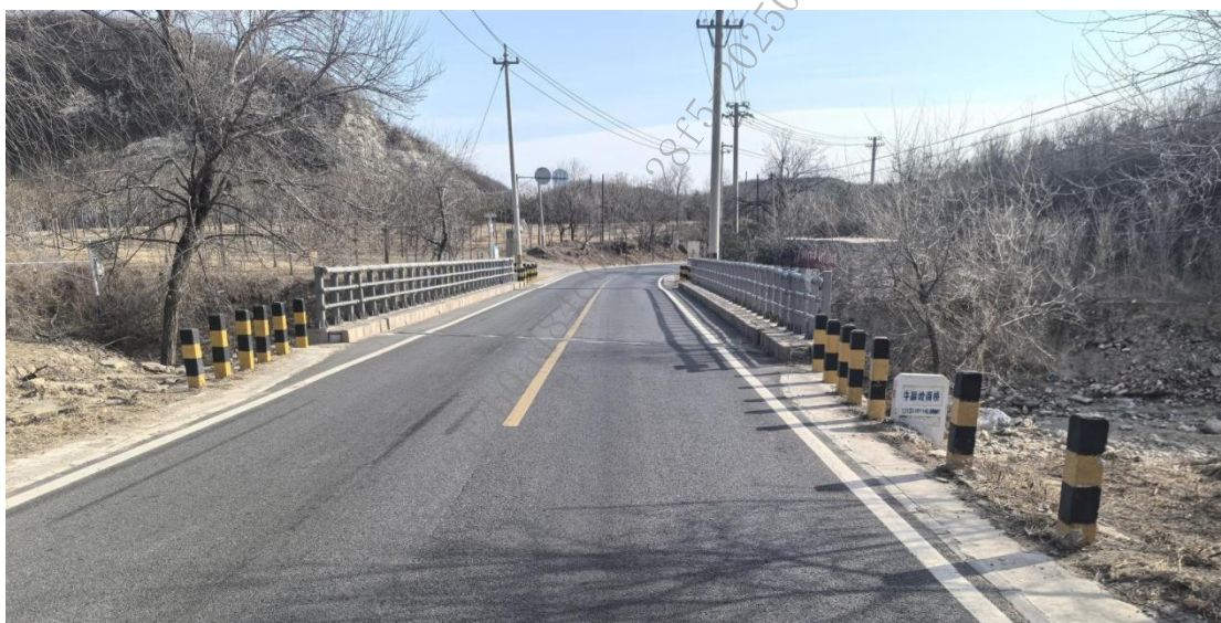
图 6.9-7 3 号桥桥位现场照片
