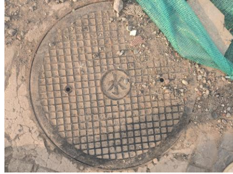
项目内的检修井
