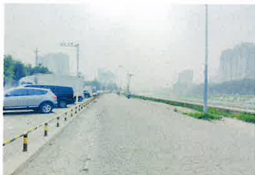
项目南侧现状道路
