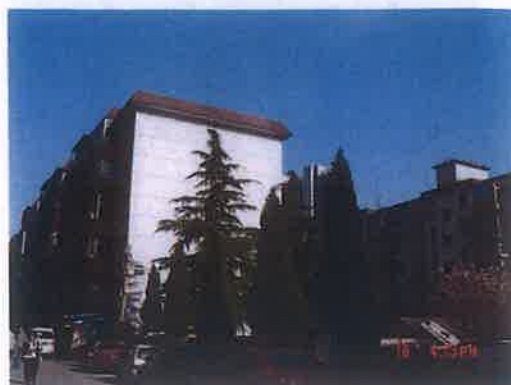
照片2 北侧农机公司宿舍楼
