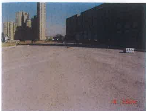
照片 7 场地内施工完毕的市政路
