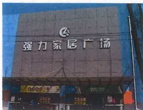
照片 8 场地内待拆的楼房
