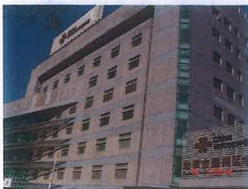
照片3 北侧联通大楼
