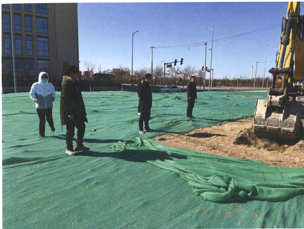
图七 院领队与甲方进行现场调查
