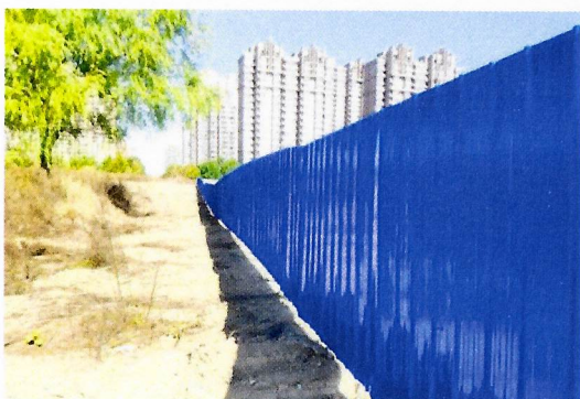
项目西侧围挡
