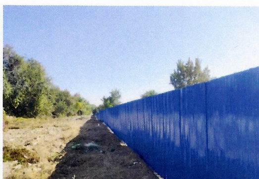
项目北侧围挡
