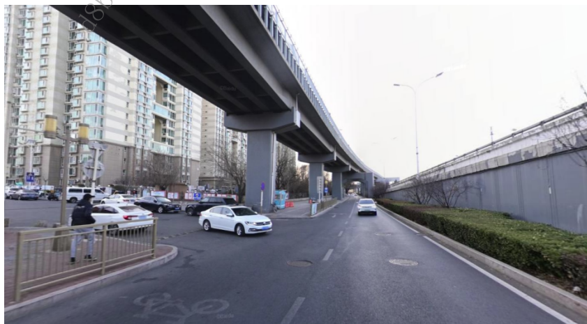
现状地铁一号线（高架）
