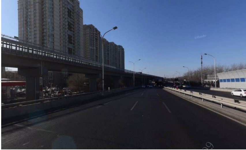
现状京通快速路（填方挡墙）
