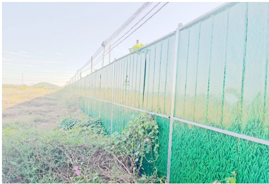
项目西侧围挡
