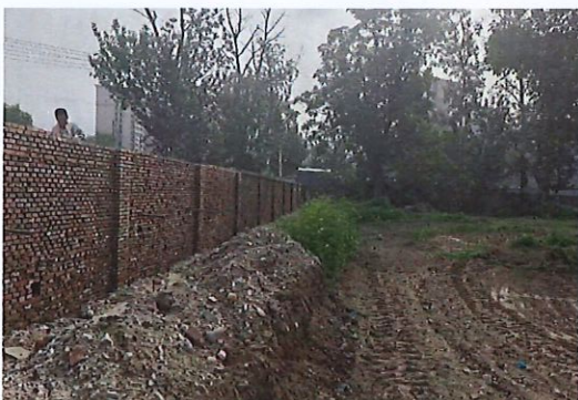
项目东侧围墙
