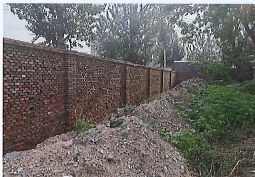
项目北侧围墙
