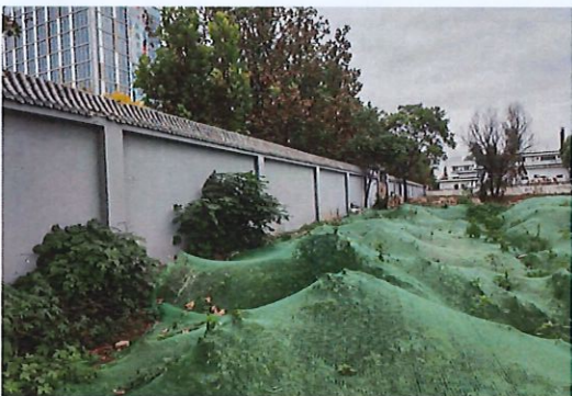
项目西侧围墙
