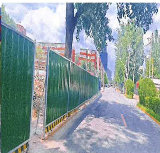
现状道路围墙
