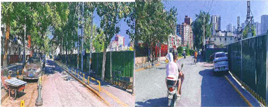
现状道路围墙
