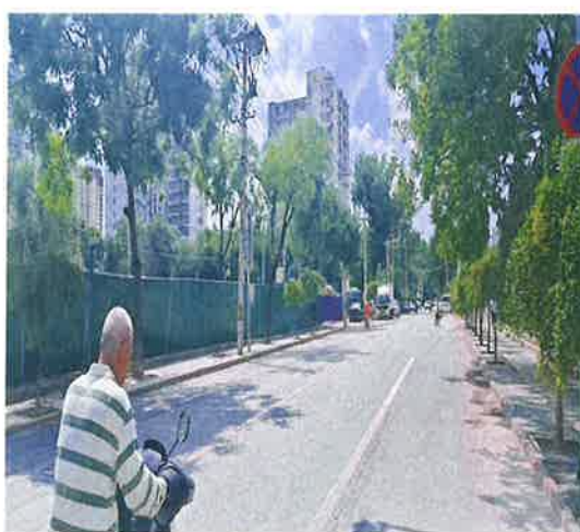
现状道路围墙
