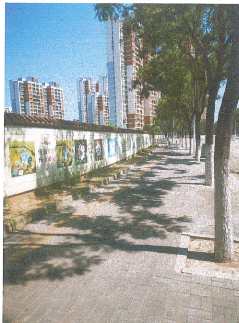
项目南侧围墙
