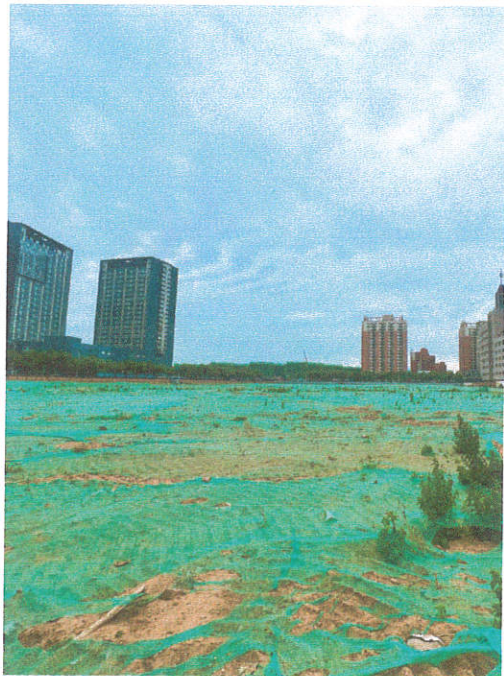
土地平整情况（北）
