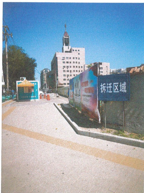
项目西侧围挡
