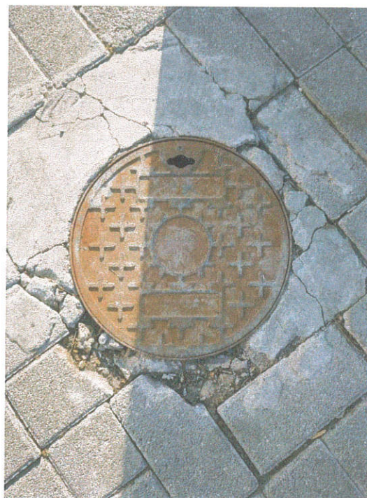
项目内不明用途检修井
