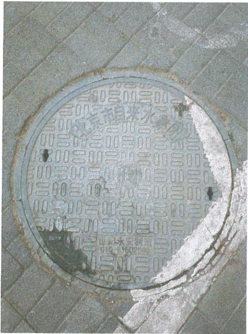
项目内阀门检修井
