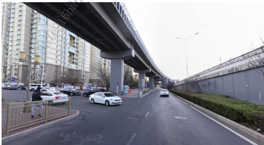
现状地铁一号线（高架）
