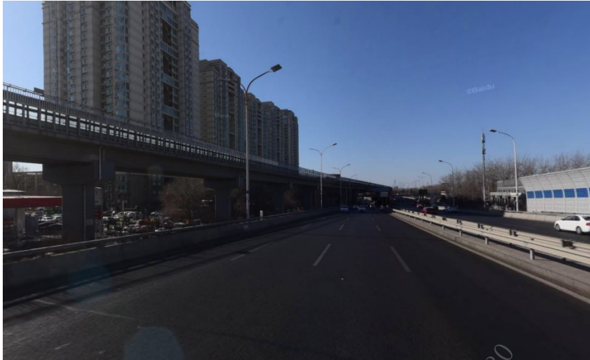
现状京通快速路（填方挡墙）
