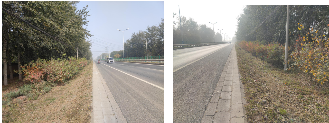
图 3.4-1 村外段段附属设施现状
