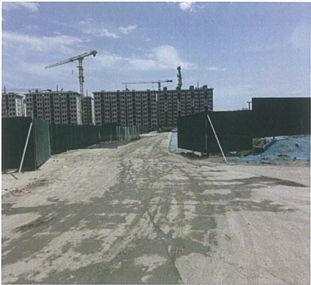
项目内硬化路面
