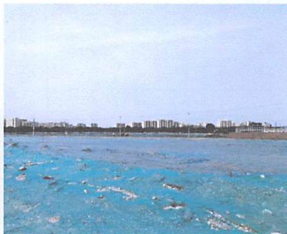
项目内土地平整情况
