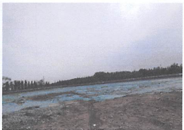
项目内土地平整情况
