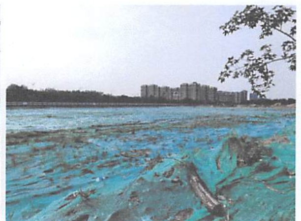
项目内土地平整情况
