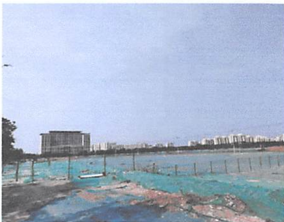
项目内土地平整情况
