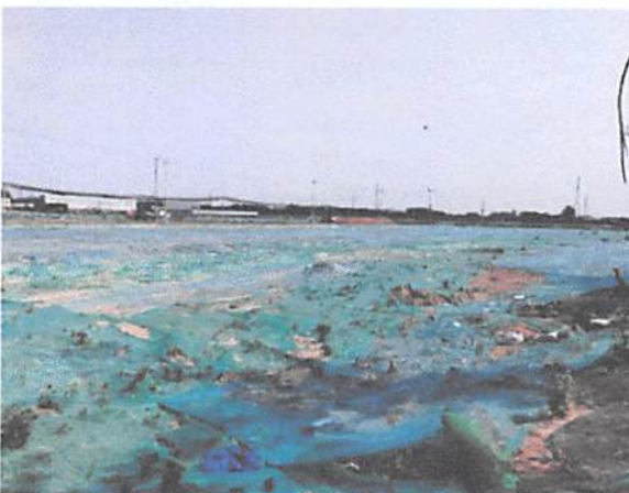
项目内土地平整情况
