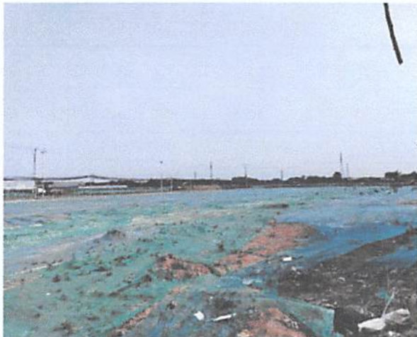
项目内土地平整情况
