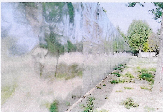
项目北侧围挡
