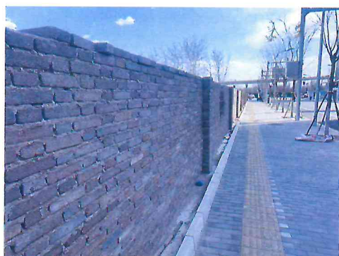
项目内的围墙
