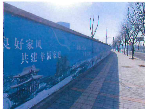
项目内的围墙
