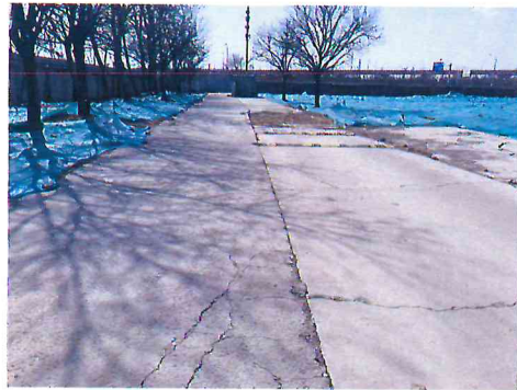
项目内的路面
