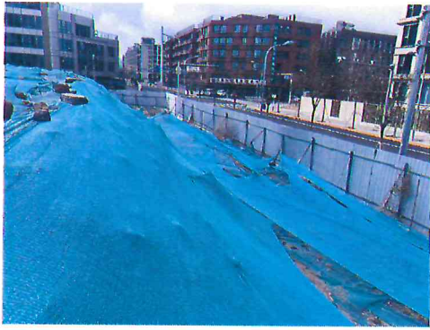
项目内加固的陡坎
